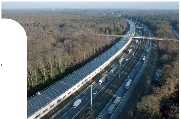
Tunnel solare di 4MWp sulla linea ferroviaria fra Anversa e Rotterdam.
