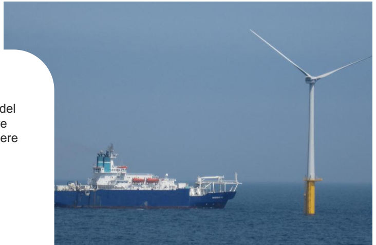
Parco eolico offshore di 165 MW al largo delle coste del Belgio.
