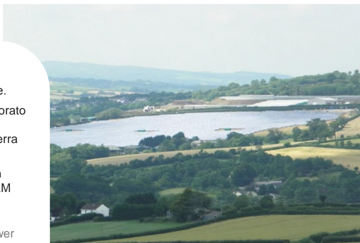
Parco fotovoltaico di 5 MWp installato in Cornovaglia, Regno Unito.
